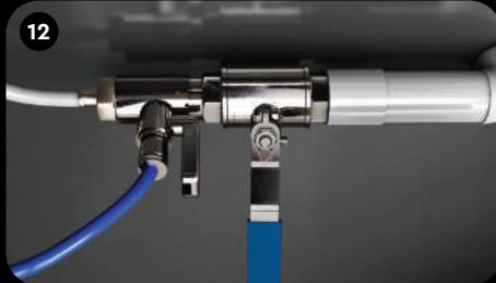
Открутите от крана гайку для трубы. Наденьте гайку на синюю трубку. С усилием натяните трубку на штуцер шарового вентиля до упора и закрутите гайку.
