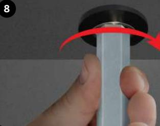
Закрепите кран на мойке при помощи ключа на 14 мм.
